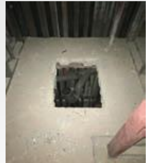
حفره جهت نصب سبب
