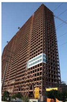
برج هزاره سوم، تهران، در حال ساخت
