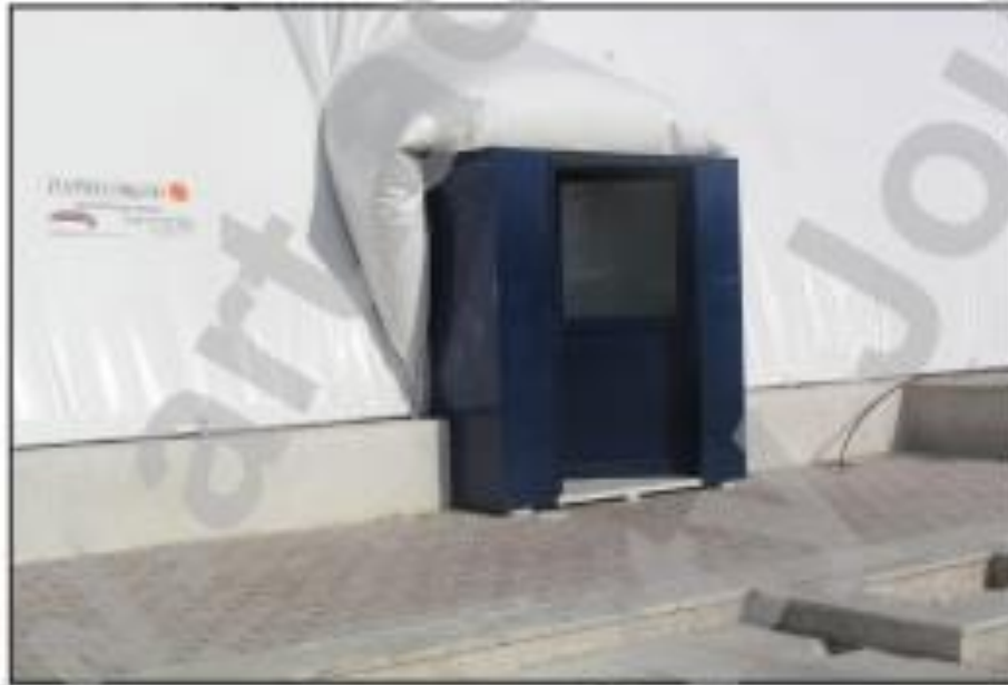
شکل ۸ دسترسی به درون سازه متکی بر هوا با استفاده از قفل هوایی منبع: بروشور شرکت فندوله
