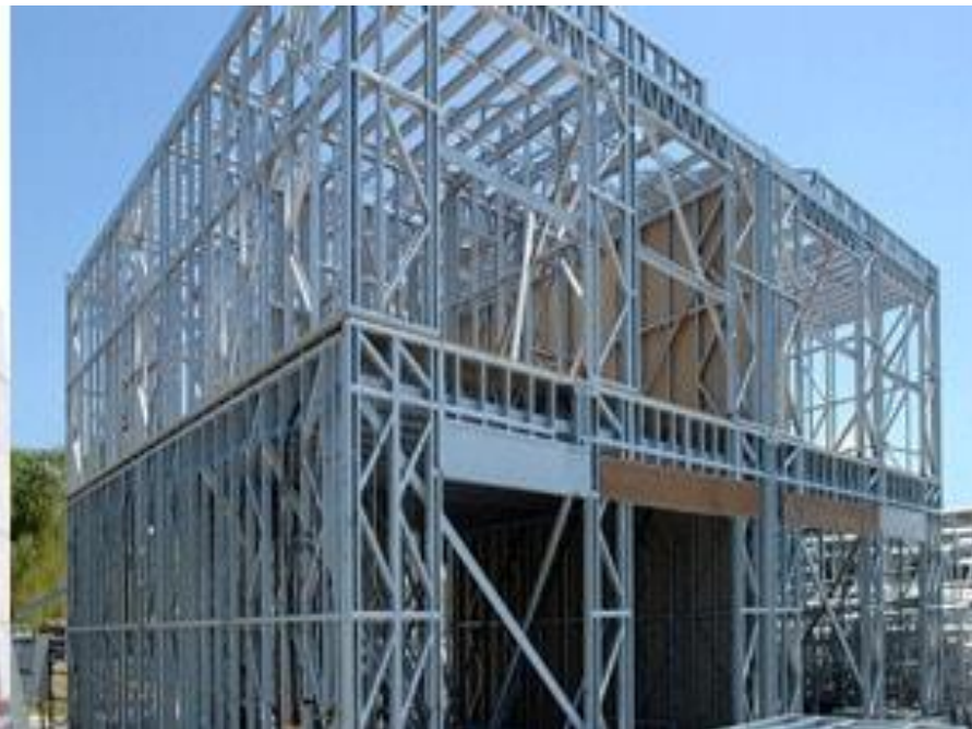
دو نوع سیستم دیوار باربر به عنوان سیستم های باربر جانبی سازه (قاب فولادی سبک و دیوار باربر بتنی)
