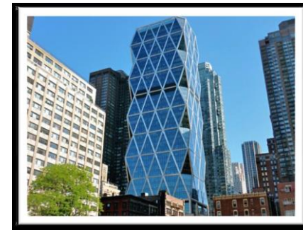
برج هرست، نیویورک
