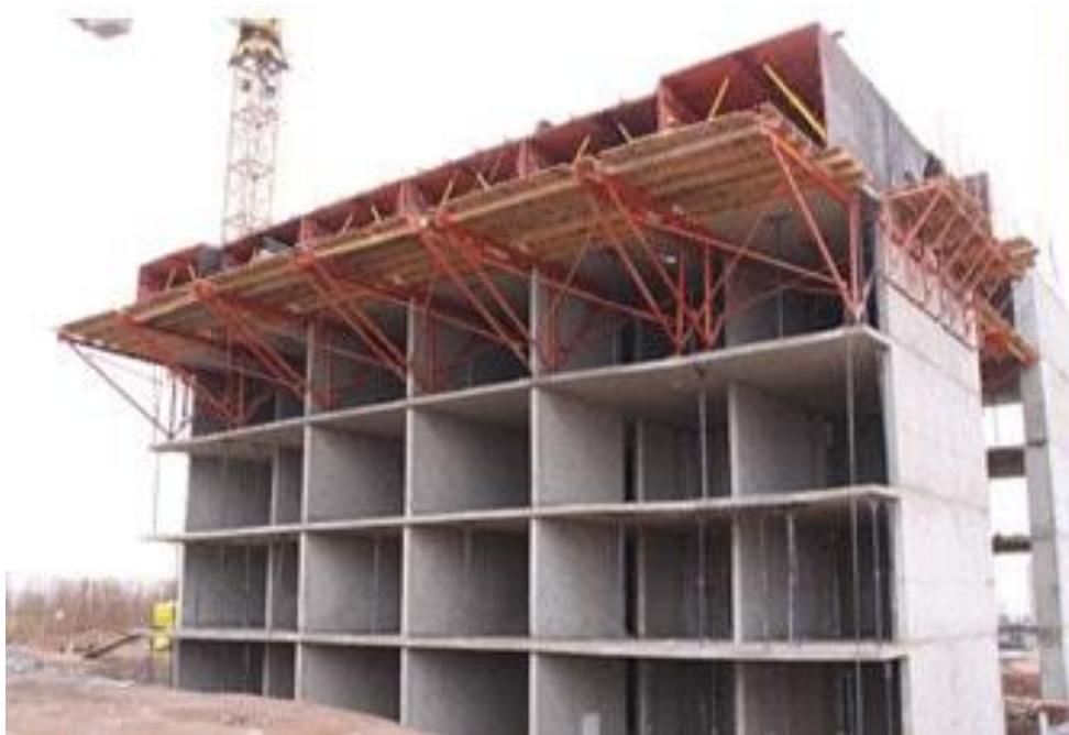
دو نوع سیستم دیوار باربر به عنوان سیستم های باربر جانبی سازه (قاب فولادی سبک و دیوار باربر بتنی)
